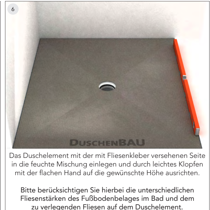
Erdfeuchte Mörtelmischung (1 Teil Zement / 4 Teile Sand) herstellen oder fertige Zement-Mörtel-Mischungen (im Baumarkt erhältlich) benutzen. Diese Mischung auf Höhe bringen.
